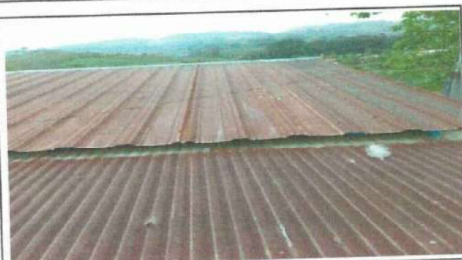
Foto 3: Sustitucion de laminas galvanizadas por laminas troqueladas para el modulo 2 (aulas del Centro Educativo.)
