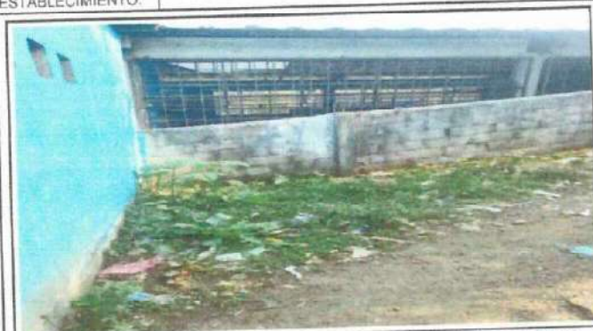
Foto 1: Aplicación de pintura en muro interior y exterior de los módulos del establecimiento educativo.
