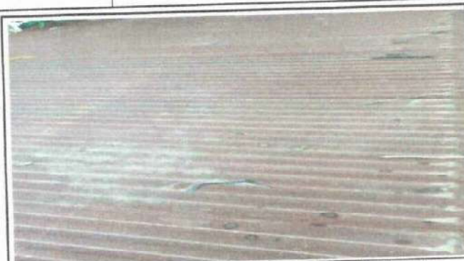
Foto 2: Cambio de techo del modulo 1 del Centro Educativo (sala de docentes y direccion)
