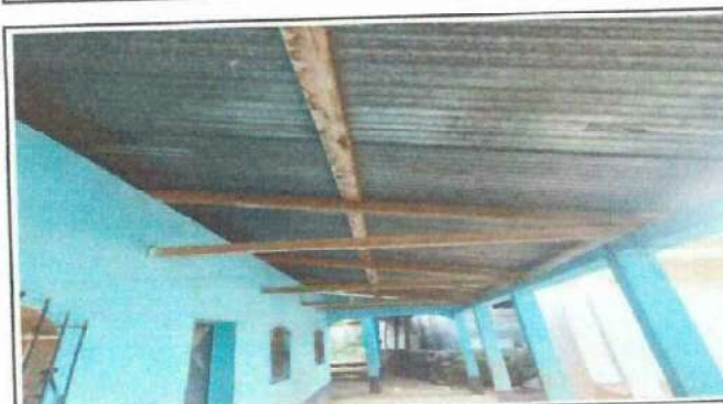
Foto 4: Sustitucion de Vigas de Madera por estructura de techo (costaneras) y suistitucion de laminas. Area del corredor del Establecimiento.
